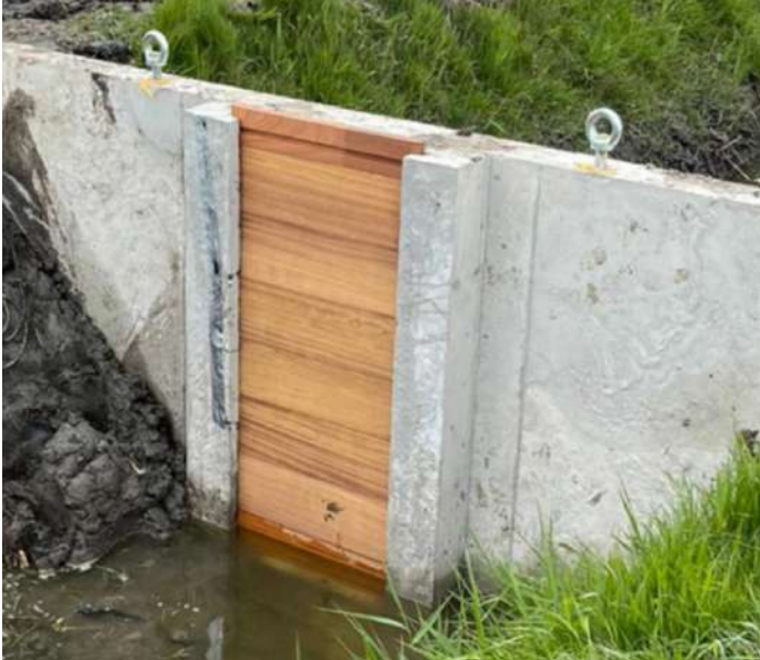
Figuur 22. Zoete stuw (boven) en een geplaatste zoete stuw (onder). Zoet water drijft op zout water. Door de opening onder in de stuw laat deze stuw het zoute water door, maar houdt hij het zoete water wat bovenop drijft vast. Bron: zoetestuw.nl
