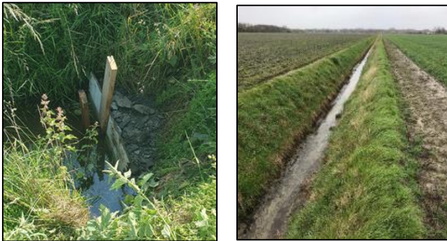
Figuur 12: Stuwende constructie (niet waterdicht) voor een duiker geplaatst (links) en de gestuwde kavelsloot (rechts).
