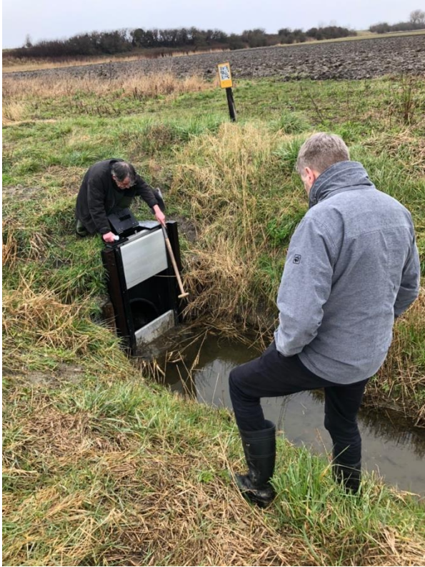
Afbeelding 2. Waterconserveringsstuw in het fieldlab Brouwershaven-Zonnemaire (foto Buro Waterfront)
